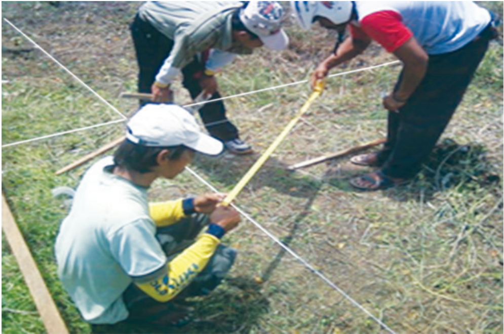
Gambar 6.1 Seorang tukang sedang mengukur kesikuan lahan
